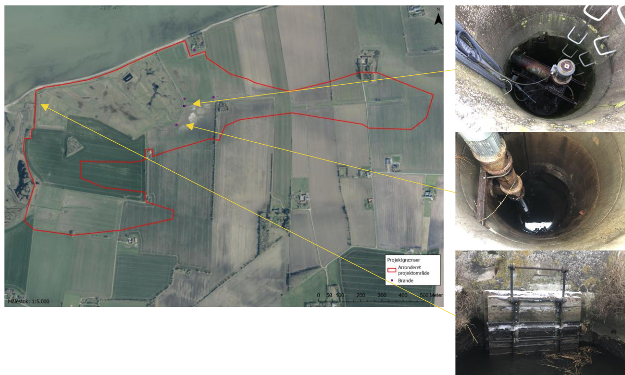
Figur 2-6: Fotos af drænbrønde og sluse i projektområdet.
