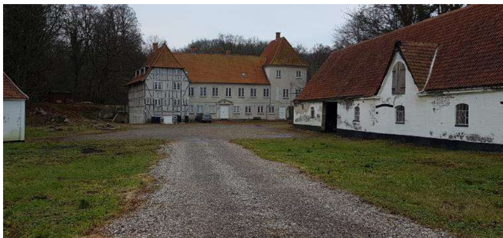
Figur 2. Hovedhuset på den gamle skovmølle, der ligger umiddelbart syd for undersøgelsesområdet.
