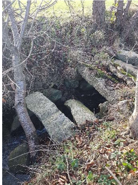
Figur 6. Ældre kampestensbro ved st. 260 m.
