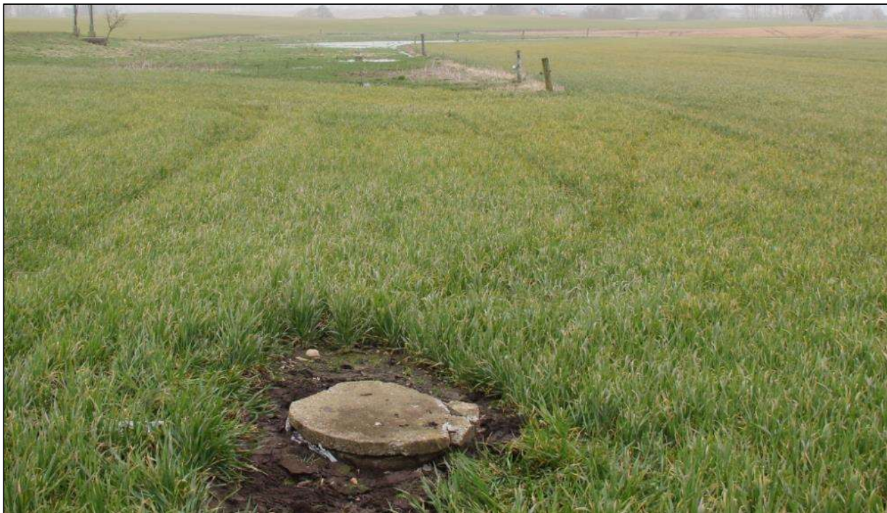
Figur 11: Udsigt fra indmålt brønd i afvandingssystem 1 mod øst, hvor dræningssystemet angiveligt har indløb i en ny brønd, der stod under vand.
