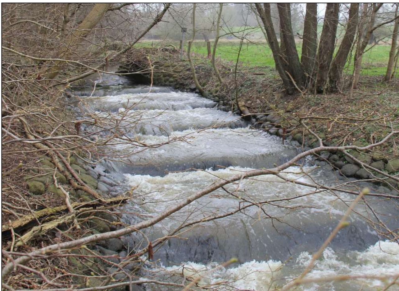
Figur 3: Bro og fisketrappe ved. st.12.482-12.466, umiddelbart hvor vandløbet har sit indløb i undersøgelsesområdet.
