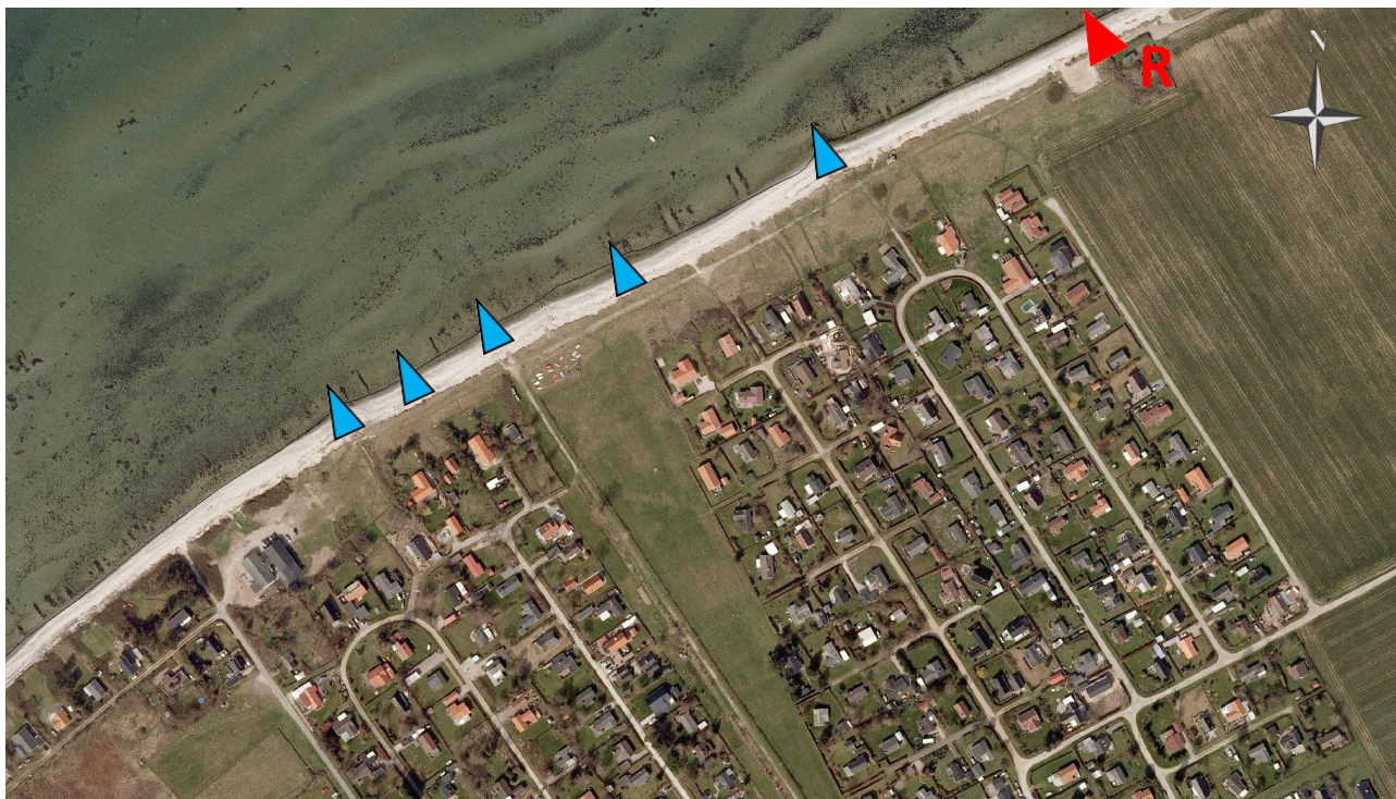
Overblik over registrerede regnvandsudløb ved Skåstrup V.
