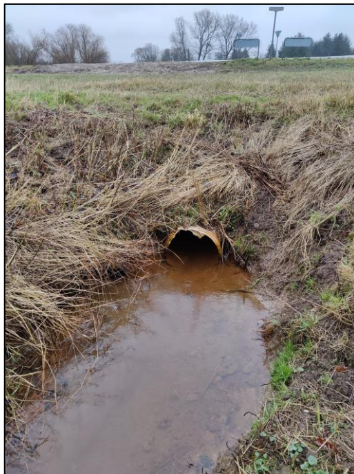
Figur 4: Udløb fra Farsbøllefløbets rørlagte del, til den åbne del i st. 1.411 m
